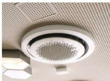
Montáž v podhledu
